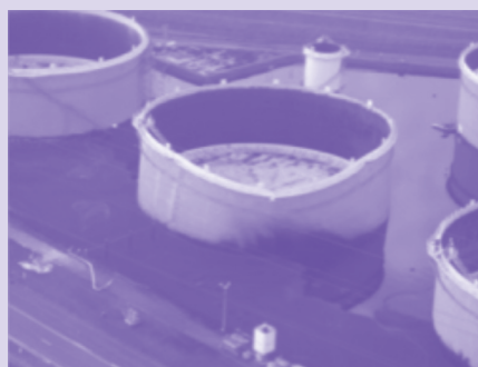
Figure 1 : Rupture d'un bac de pétrole brut – Kallo – 2005 Source : BARPI
