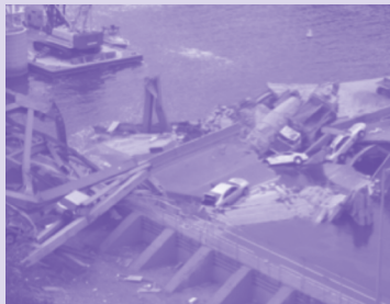
Figure 2 : Effondrement d'un pont routier - Minneapolis - 2007 Source : FEMA
